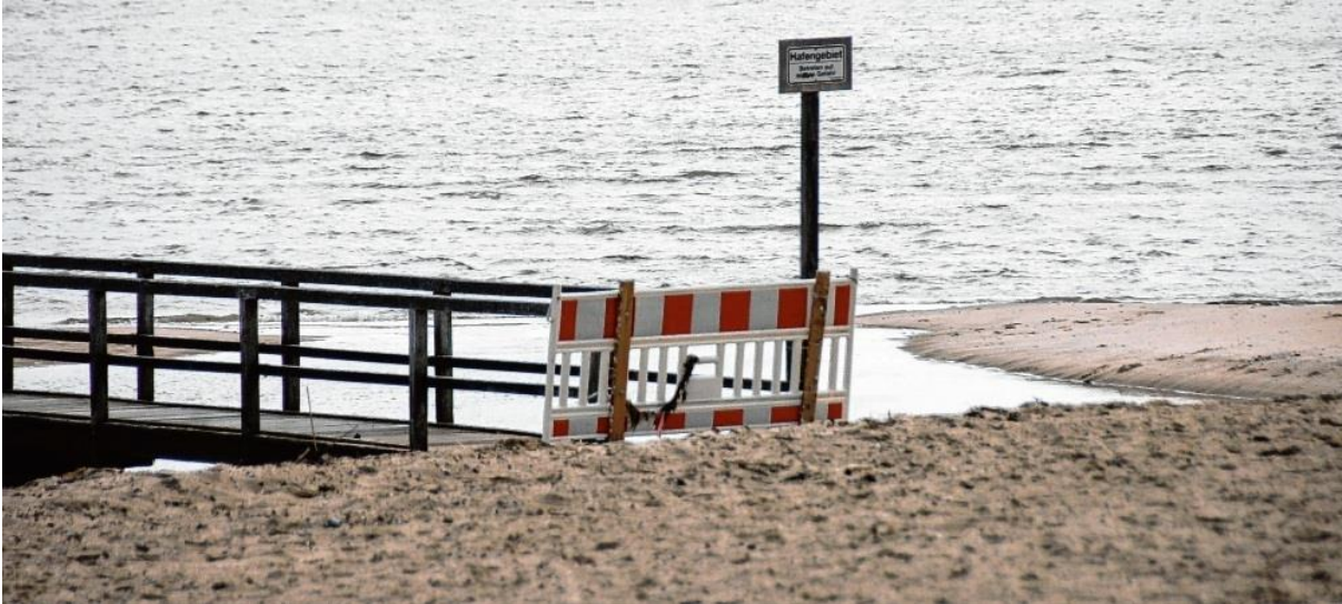
Die Brücke ist aus Sicherheitsgründen gesperrt. Kölschbach
