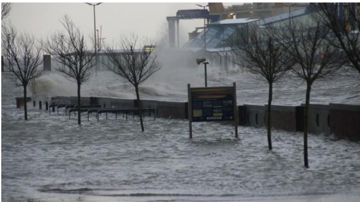
Die Brecher knallen an die Mauer beim Wyker Fähranleger
