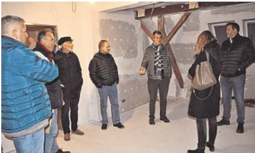
Die Ausschussmitglieder besichtigten die Baustelle im ehemaligen Zollamtsgebäude. Foto: Christel Leipersberger-Nielsen
