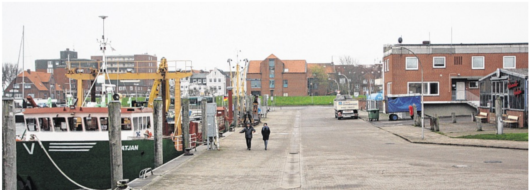
Nicht nur an trüben Novembertagen trostlos: Die Westkaje des Wyker Binnenhafens.
