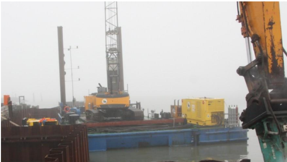
Das Ungetüm ist auf dem Ponton den Wetterkapiolen ausgesetzt
