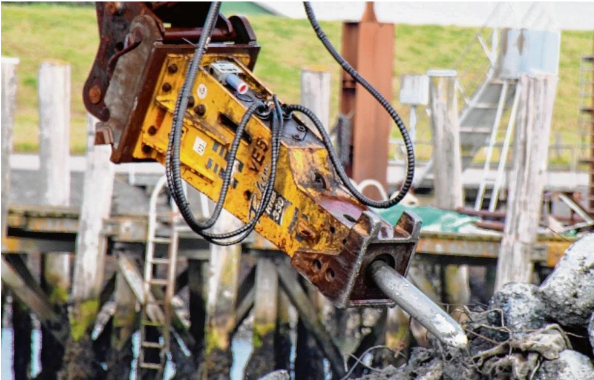
Bagger mit Meißel: Das Unterwasserfundament der Brücke ist abgetragen
