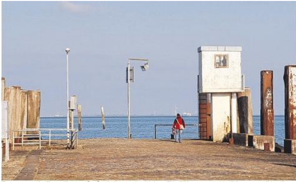
Das marode Pegelhaus (re.) wird verschwinden. Der Wasserstands-Messer soll in einem hübschen Leuchtturm untergebracht werden. Foto: pk
