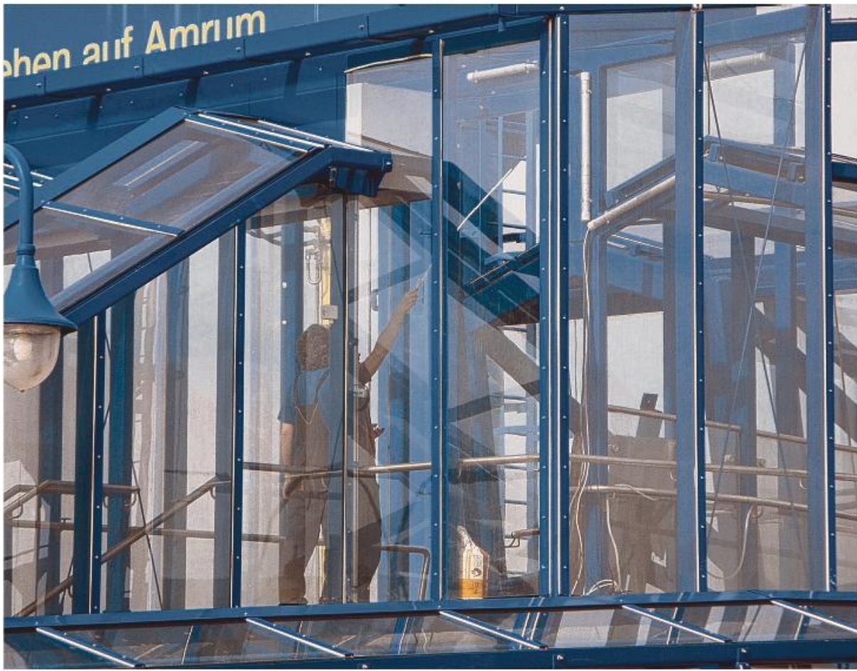
Für Passagiere gesperrt: Weiterhin werden sich Arbeiter der Stahlbaufirma in den Neubauten aufhalten. Foto: oe
