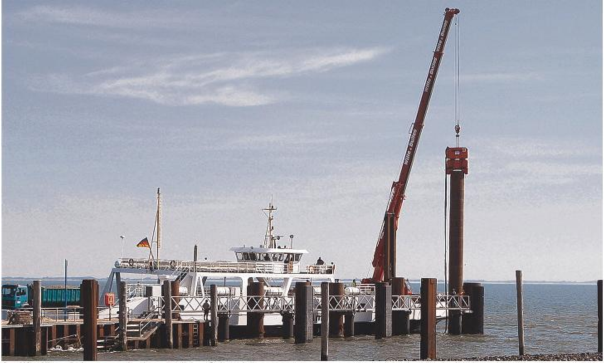
Am Wittdüner Anleger wurde ein zusätzlicher Schutzdalben gesetzt. Foto: oe
