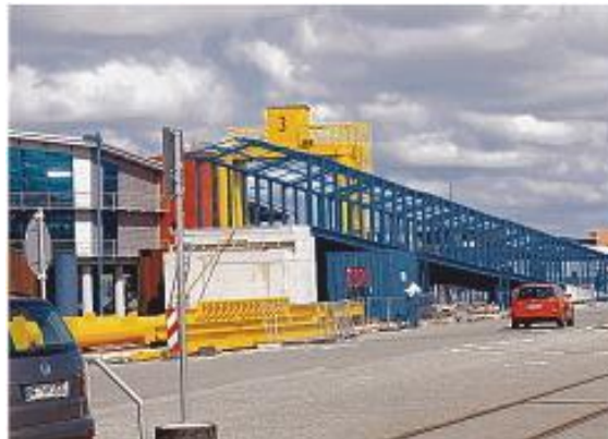
2,5 Millionen Euro teure Rampe steht kurz vor der Fertigstellung
