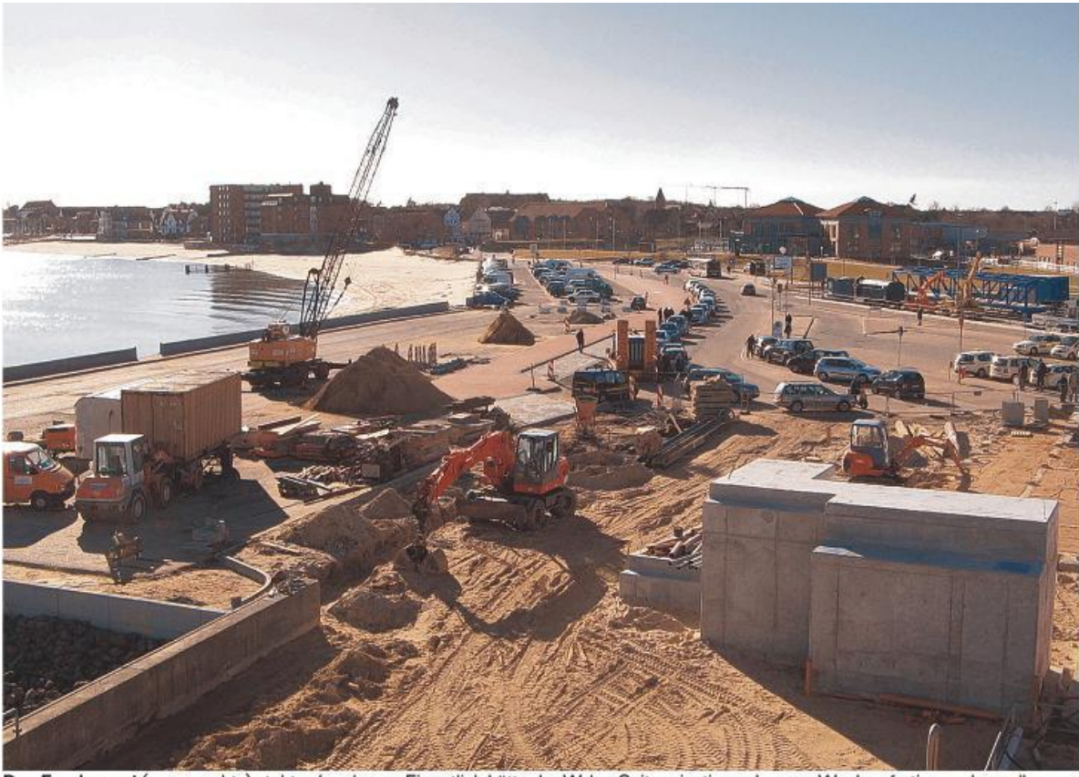
Das Fundament (vorne rechts) steht schon lange. Eigentlich hätte der Wyker Seiteneinstieg schon vor Wochen fertig werden sollen.
