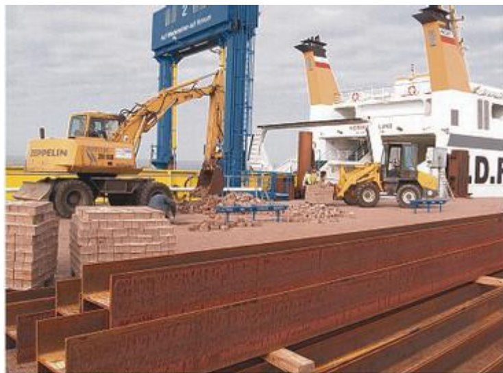
In Wittdün haben die Arbeiten gerade erst begonnen. Foto: oelers
