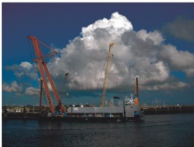
Der kombinierte Spülbagger und Schwimmkran „LVP1“ tauschte den defekten Dalben an der Molenspitze aus. Fotos: Hans Pohlmann
